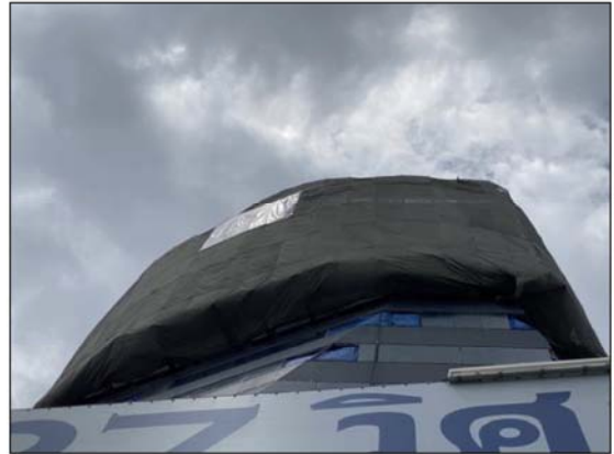
ภาพที่ 2.2-8 ผ้าใบก่อสร้าง (Mesh Sheet)
