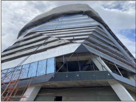
ภาพที่ 2.2-8 ผ้าใบก่อสร้าง (Mesh Sheet)
